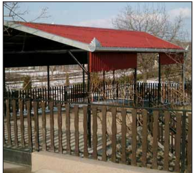
Colocación de placas bituminosas coloreadas
