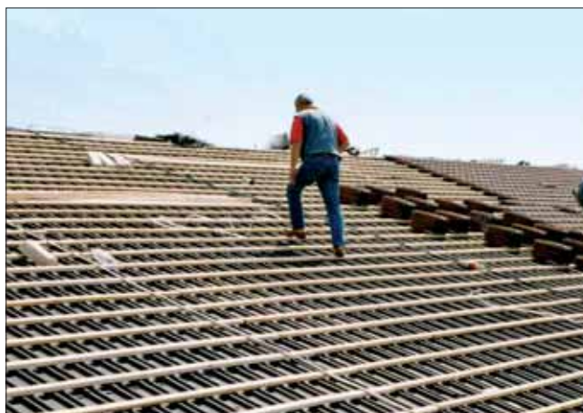
Colocación de gutta® 3 punti para recubrimiento con teja plana
