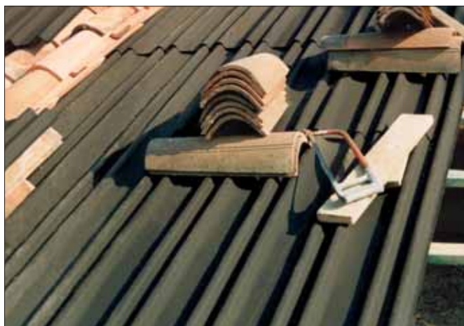
Detalle de colocación de gutta® 3 punti
