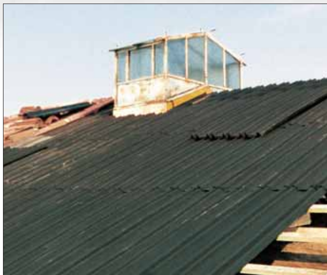
Colocación de gutta® 3 punti para recubrimiento con teja curva
