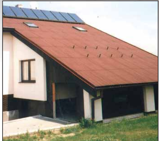
Colocación de placas bituminosas coloreadas
